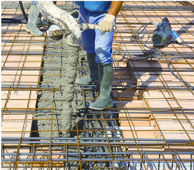
Für den Bau eines Gewerbegebäudes dieser Höhe musste der beste Betonverflüssiger verwendet werden, der auf dem Markt verfügbar ist, denn der Beton musste bis ins 80ste Stockwerk rund 259 Meter über dem Erdboden hochgepumpt werden. Außerdem musste der Beton für die verschiedenen Stockwerke aufgrund der Interaktion des Bewehrungsstahls beim Setzmaß einen Toleranzbereich von 160 bis 200 mm abdecken.
